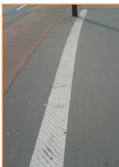
Abbildung 29: Begrenzung aus Naturpflaster (links) und Kaltplastik (rechts), Bremen
