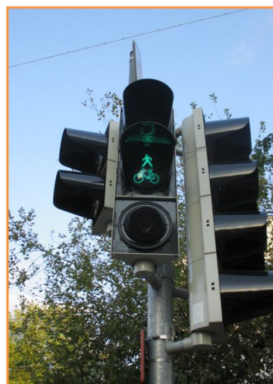
Abbildung 23: Lichtsignalanlage mit in den Ampelkopf integrierter Zusatzeinrichtung für Blinde und Sehbehinderte, Bremen
