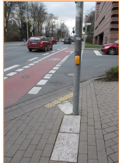
Abbildung 19: Gesicherte Querungsstelle mit falsch ausgerichtetem Richtungsfeld
