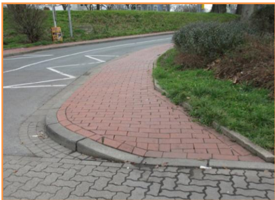
Abbildung 11: Querneigung und unzureichende Absenkung
