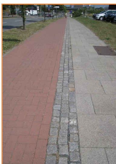
Abbildung 29: Begrenzung aus Naturpflaster (links) und Kaltplastik (rechts), Bremen
